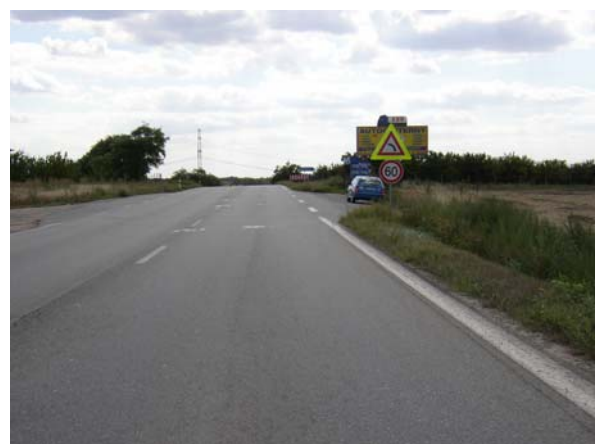
Obr. 4: Špatný kontrast značky na nevhodném pozadí (stará I/52 Brno-Pohořelice)
