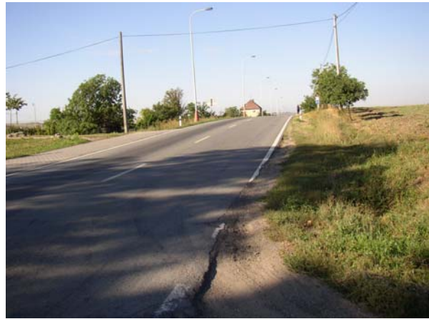
Obr. 19: Nedostatečný dohled na hlavní silnici (II/430, Rousínov)
