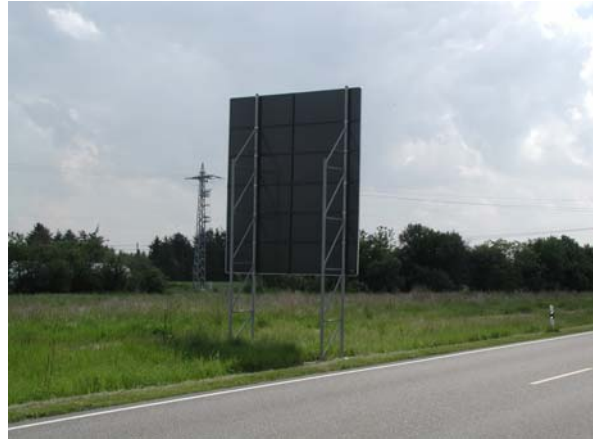
Obr. 6: Příhradové podpěry s možností přejetí (SRN)
