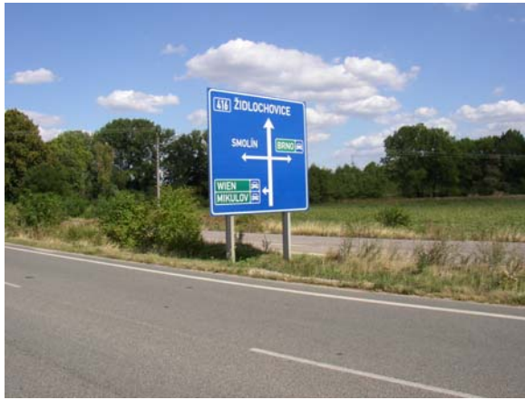
Obr. 5: Agresivní podpěrné konstrukce profilu I (silnice II/416 Pohořelice-Židlochovice)
