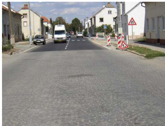
Obr. 12: Náhlá změna adheze povrchu (Pohořelice)
