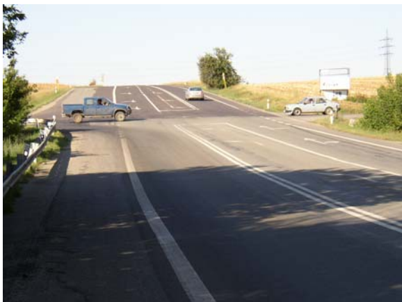
Obr. 22: Rozhlehlá a nebezpečná kolizní plocha (II/430, Vyškov-Brno)
