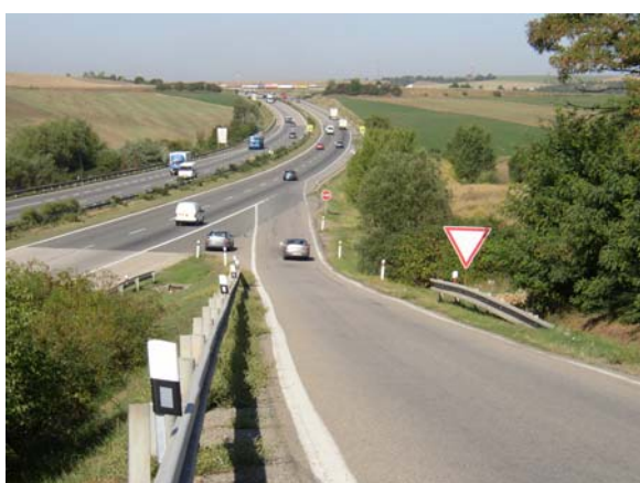
Obr. 11: Chybějící připojovací pruh (D 1, Rohlenka)
