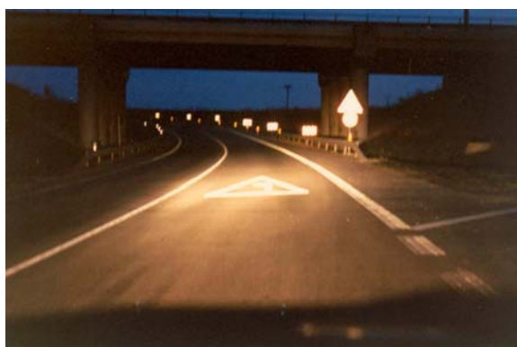
Obr. 2: Dříve nehodová zatáčka na okraji Písku (noc)
