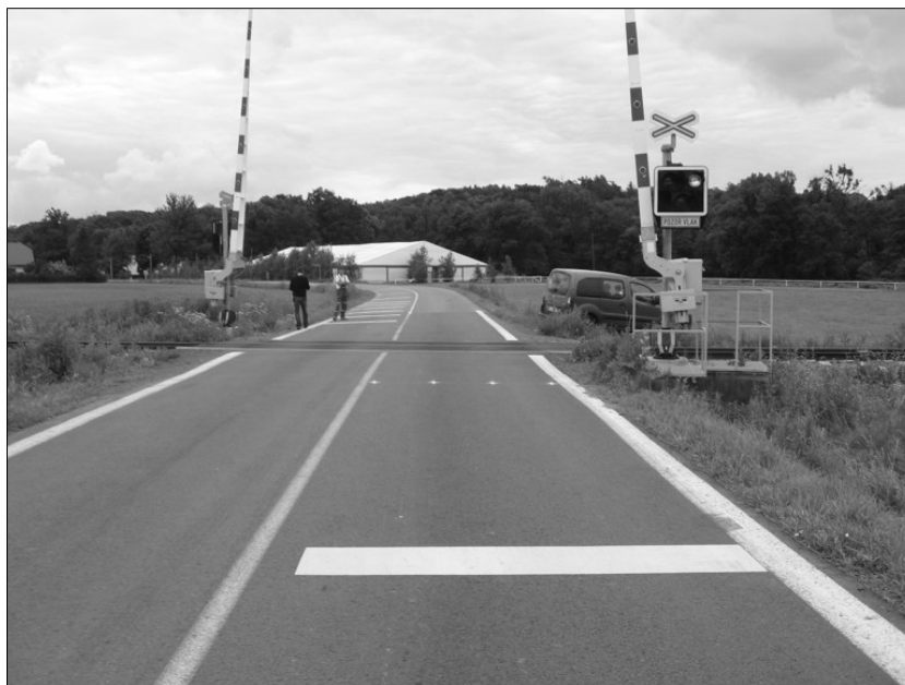
Obr. 4: Světelná závora v Oticích.
