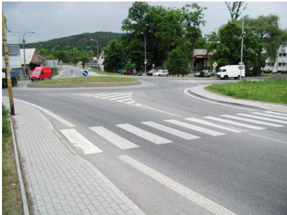
Obr. 7: Chybějící ochranný ostrůvek (Liberec, ČR)
