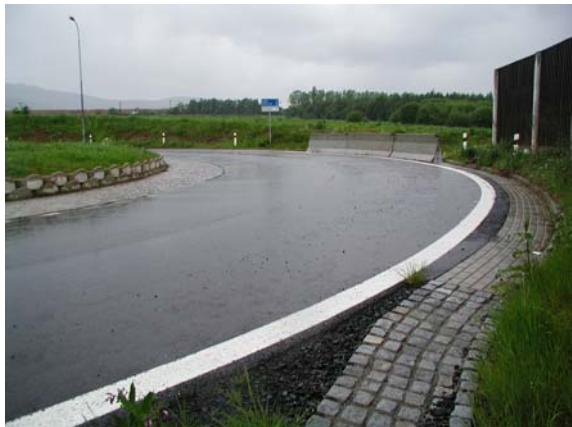
Obr. 1: Příliš široký okružní pás (Liberec, ČR)
