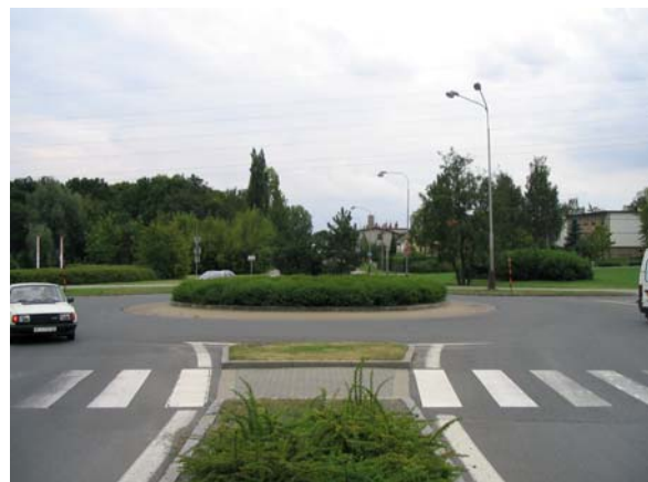
Obr. 10: Ochranný ostrůvek nezpevněný (Orlová, ČR)
