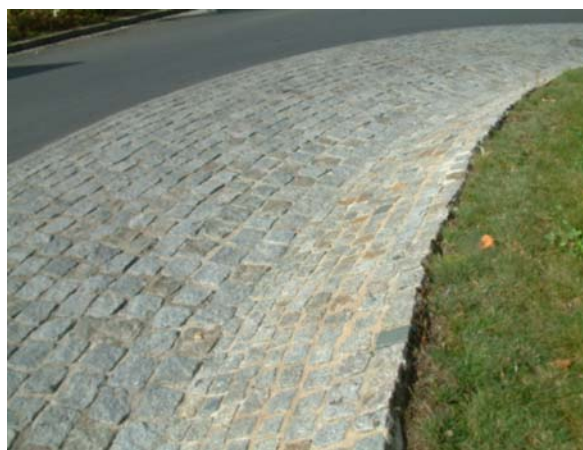
Obr. 4: Kvalitní dlážděný prstenec (Radeberg, SRN)
