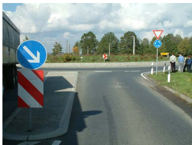
Obr. 5: Tangenciální (chybný) vjezd (Brno, ČR) Obr. 6: Radiální (správný) vjezd (Fischbach, SRN)
