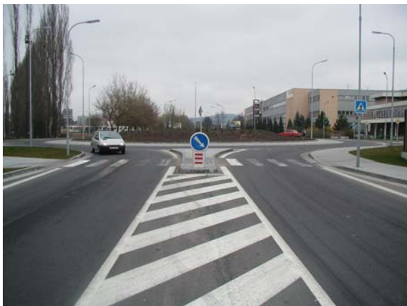
Obr. 9: Ochranný ostrůvek zpevněný (Strakonice, ČR)
