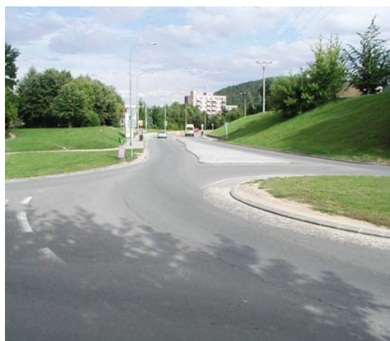
Obr. 5: Tangenciální (chybný) vjezd (Brno, ČR) Obr. 6: Radiální (správný) vjezd (Fischbach, SRN)
