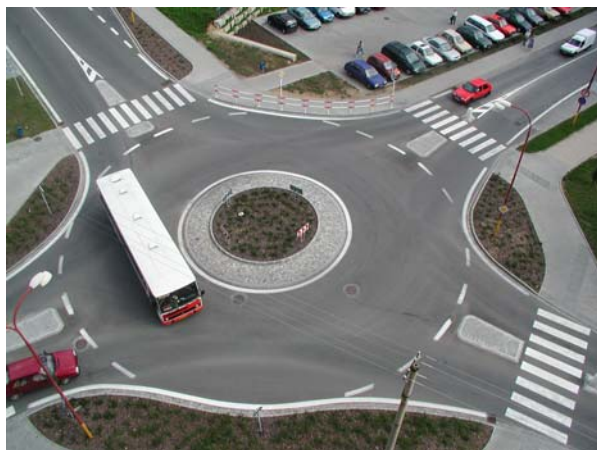
Obr. 3: Nedostatečný dlážděný prstenec (Blansko, ČR)
