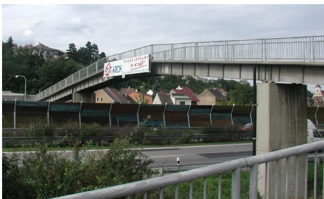
Obr. 1 – Lávka pro pěší na dálnici D5 v km 27,0
