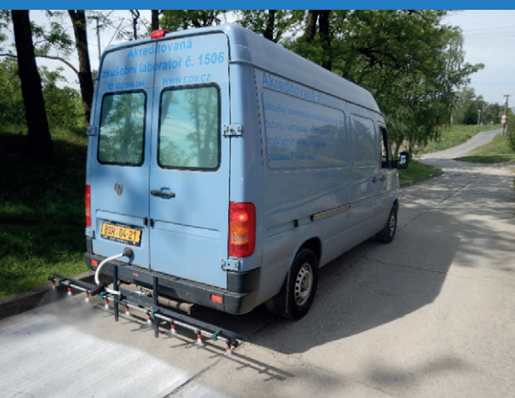
Strojní aplikace FLAX na povrch betonu
