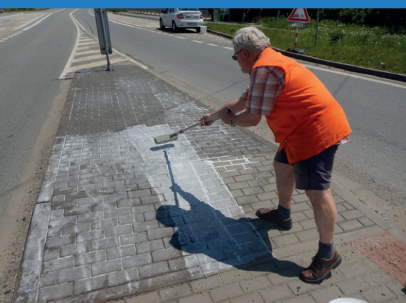
Ruční aplikace FLAX na povrch betonu
