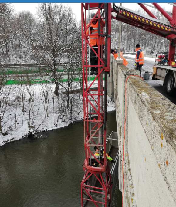
Diagnostický průzkum mostu s využitím mostní prohlížečky
