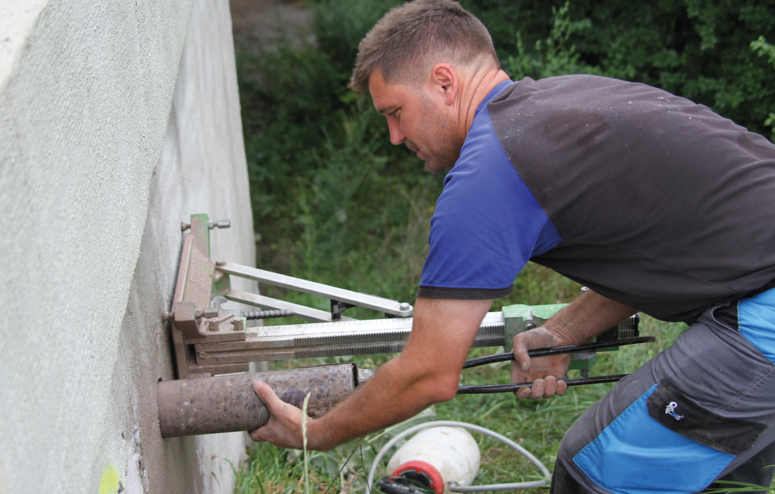
Vyjmutí jádrového vývrtnu
