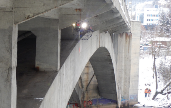
Prohlídka mostu pomocí dronu Flyability Elios 2
