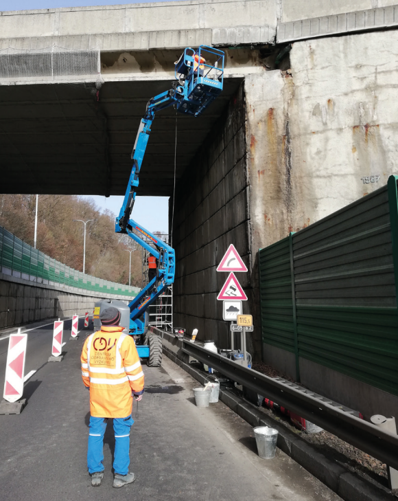
Diagnostický průzkum mostu s využitím vysokozdvíže plošiny
