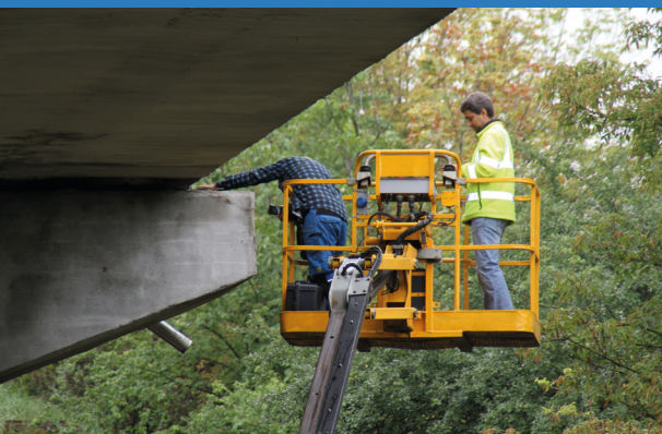
Prohlídka mostu z vysokozdvíže plošiny
