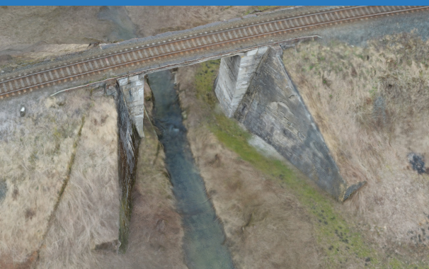
Digitální 3D model mostu vytvořený pomocí fotogrametrie fotografie: archiv CDV
