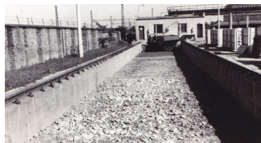
Zkušební úsek netuhých vozovek v Tišnově
