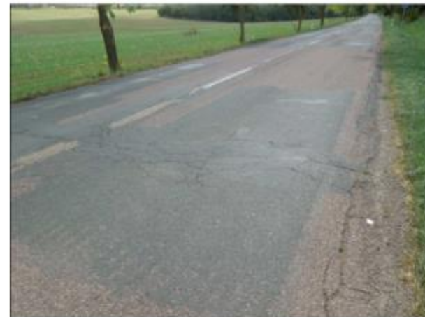
km 4,850 – síťové trhliny v levé stopě vozidel
