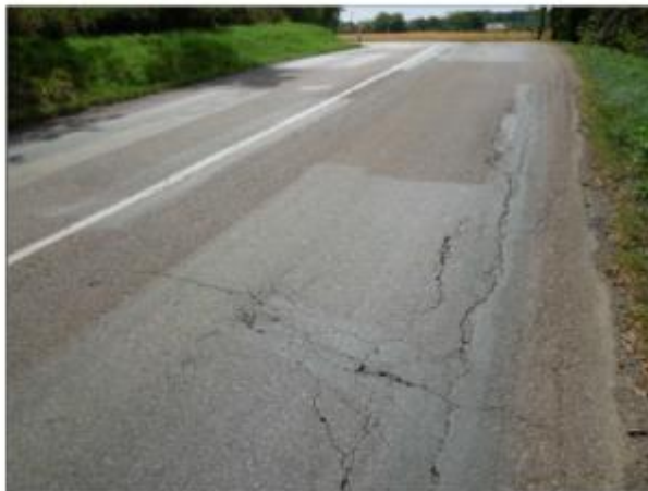
km 5,375 – trhliny, olamování okrajů vozovky
