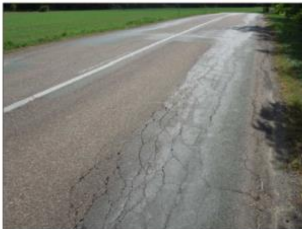
km 5,375 – trhliny, olamování okrajů vozovky
