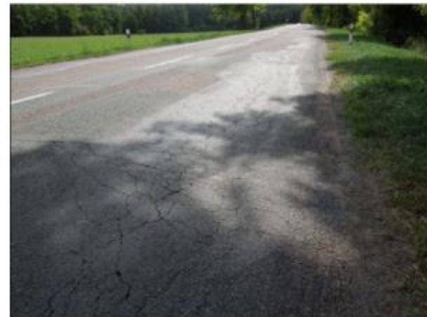
km 4,850 – síťové trhliny v levé stopě vozidel
